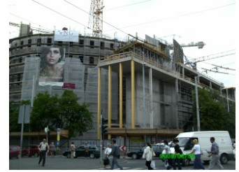
Debrecen, FÓRUM Bevásárlóközpont
